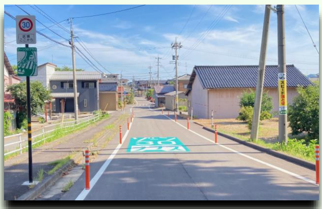
車道幅員の縮小(能美市宮竹町・ゾーン30プラスの事例)
