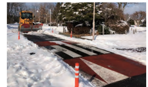
除雪作業の様子
