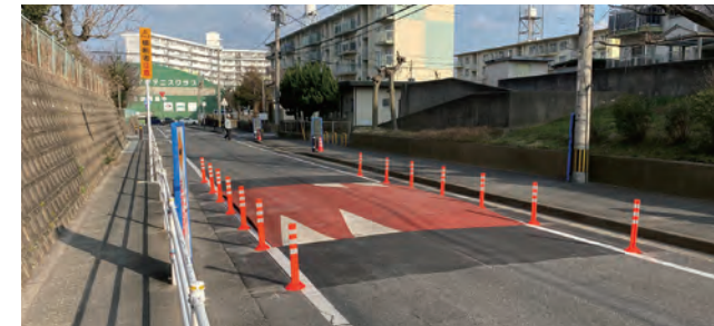
ハンプの試験設置の様子
