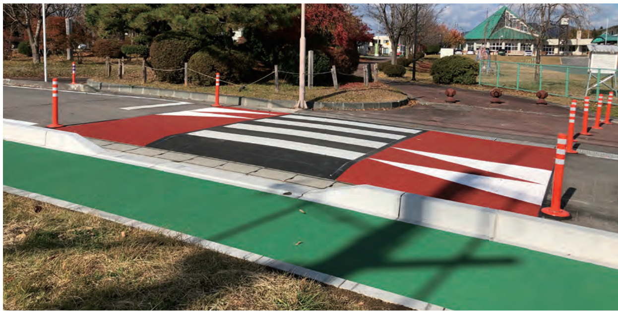
スムーズ横断歩道設置状況
